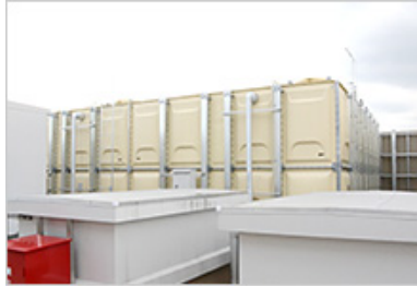
屋上に配備された貯水タンク
