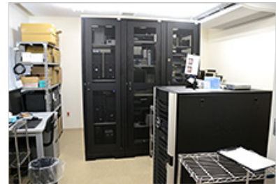
電子カルテと透析支援システムを一元管理するサーバー室
