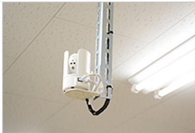
機械室には監視カメラを3台配備
