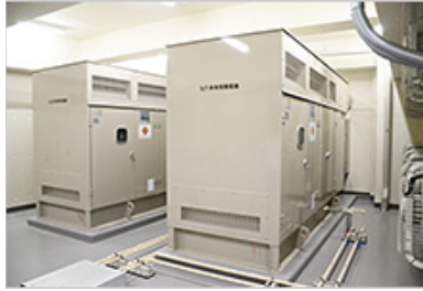
大型の非常用発電機
